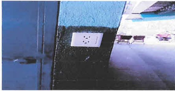
Foto 13: Sotitucion de toma corrientes
