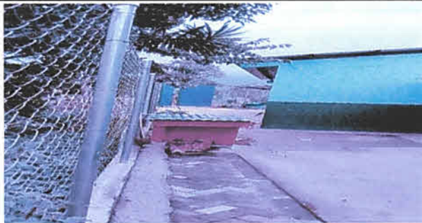
Foto 17: sustitucion de pilas de cemtno con dos lavaderos
