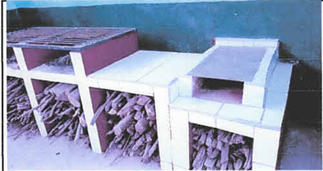
Foto 20: Sustitución de estufa rural completa, incluyendo chimenea y plancha de metal
