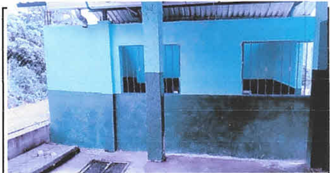
Foto 18: Sustitucion de lamina por block en area de cocina
